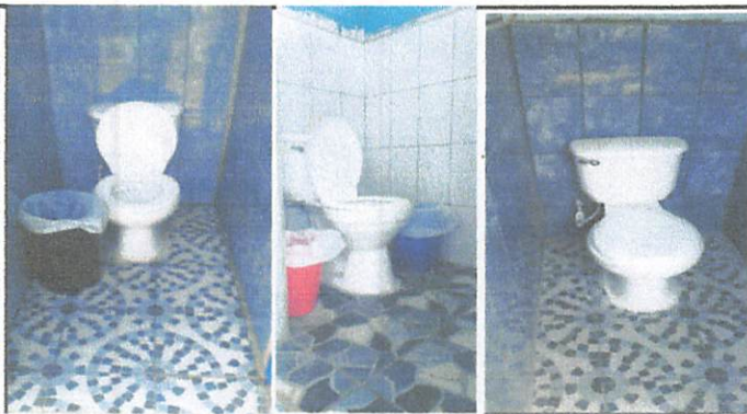
Foto 3: Reparación de sanitarios, piso y azulejo.
