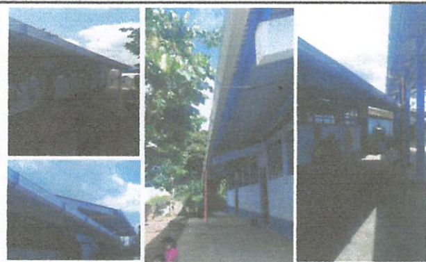
Foto4: Colocacion de canales con bases de metal y bajadas de agua en todo el techado de la escuela.
