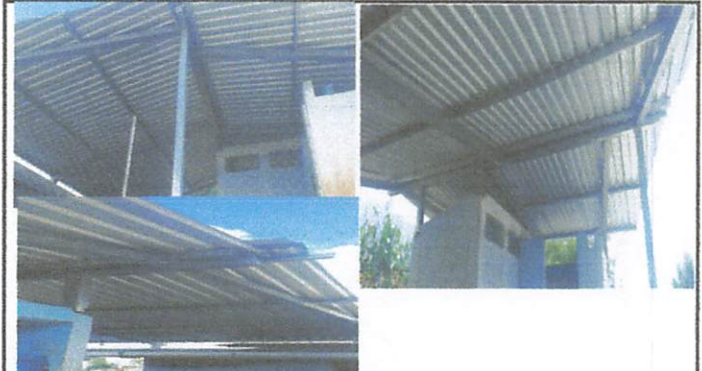
Foto 2: Reconstrucción y reparación de techado de sanitario y de cocina
