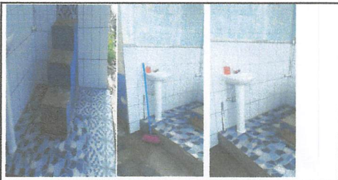
Foto6: Instalación de un lavamanos con su pedestal y área de colocacion de azulejo y piso.
