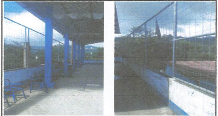
Foto2: Sustitución de malla por electromalla perimetral área de la cancha
