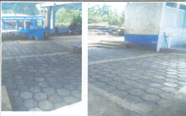
Foto3: Área de colocación de piso adoquin.
