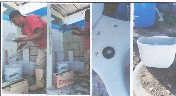
Foto 3: Reparación de sanitarios, piso y azulejo.
