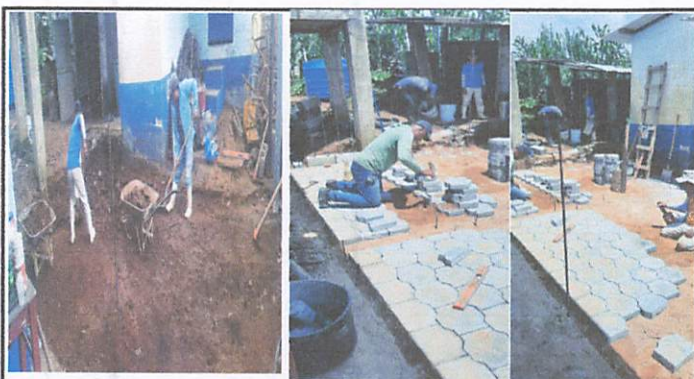
Foto3: Área de colocación de piso adoquin.
