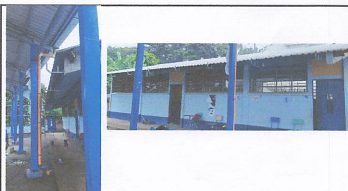
Foto4: Colocacion de canales con bases de metal y bajadas de agua en todo el techado de la escuela.
