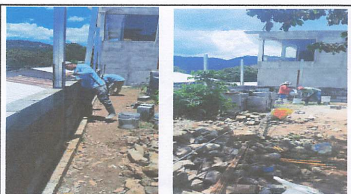
Foto 4: Levantado de pared de block y malla (muro perimetral)
