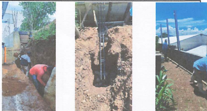
Foto 1: Construcción de muro, block y malla perimetral
