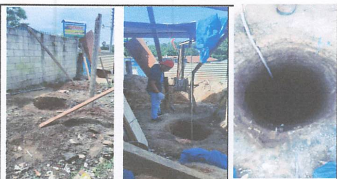
Foto5: Excavacion de fosa septica para deshechos.
