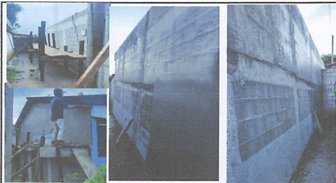
Foto1. Repello, cernido y alizado, protección contra la humedad
