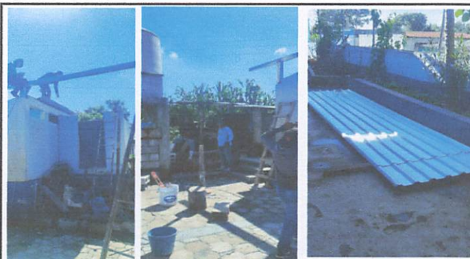
Foto 2: Reconstrucción y reparación de techado de sanitario y de cocina
