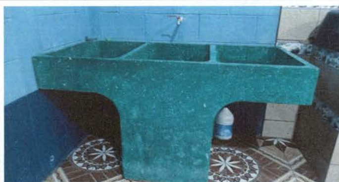
Foto 3: Instalación de una pila, más instalación de agua y salida de drenaje.
