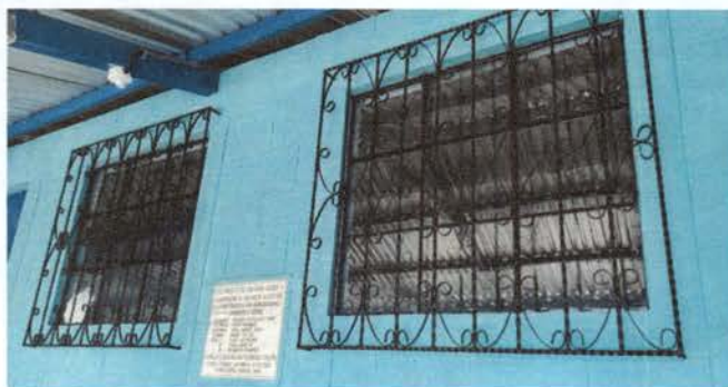
Foto 2: Trabajo y elaboración de balcones de 145x140 hierro entorchado y pintura.
