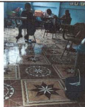
Foto 6: Colocación de piso en aula 2.
