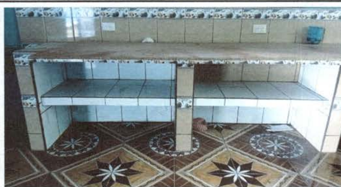
Foto 2: Construcción de Gabinete de concreto mas azulejo exterior de dos espacios 2.50 x 60 de fondo x 85 de alto.
