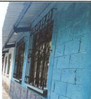
Foto 1: Corredizos 80x80 ventanales existentes.
