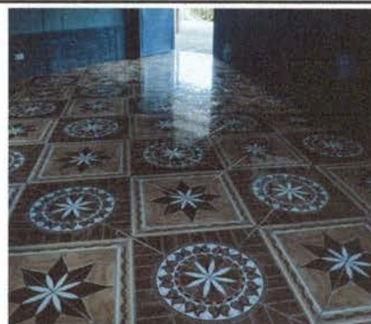
Foto 4: Colocación de piso 43x43.
