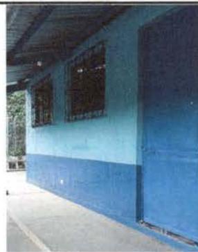
Foto 6: Mantenimiento y pintura a ventana existente.
