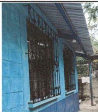
Foto 5: Cambio de vidrio de ventana.
