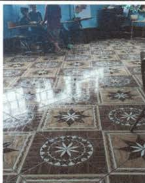
Foto 5: Colocación de piso en aula 1.
