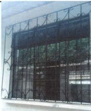
Foto 1: Corredizos 80x80 ventanales existentes.
