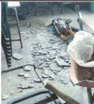
Foto 5: Resanar para nivelar torta existente en aula 1.
