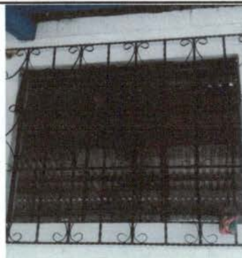
Foto 2: Trabajo y elaboración de balcones de 145x140 hierro entorchado y pintura.
