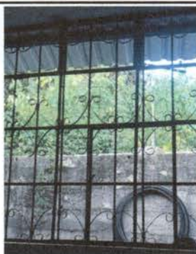
Foto 5: Cambio de vidrio de ventana.
