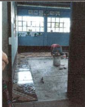
Foto 6: Resanar para nivelar torta existente en aula 2.
