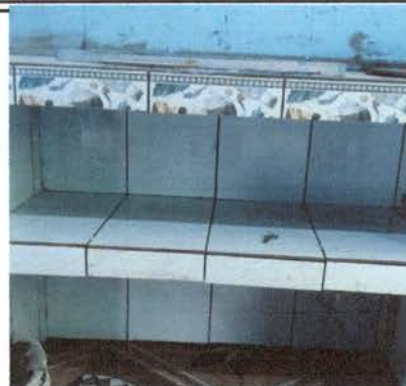
Foto 2: Construcción de Gabinete de concreto mas azulejo exterior de dos espacios 2.50 x 60 de fondo x 85 de alto.
