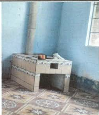
Foto 1: Construcción de pollo chimenea de tubo concreto de 4 medidas 140 largo x 90 ancho x 85 alto con plancha y azulejo
