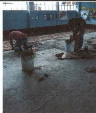
Foto 4: Colocación de piso 43x43.
