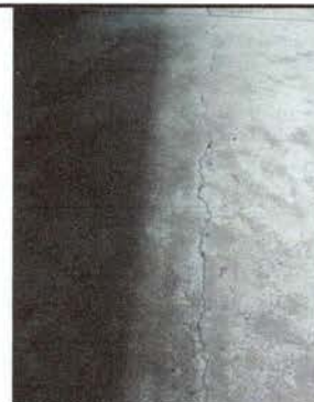
Foto 6: Resanar para nivelar torta existente en aula 2.
