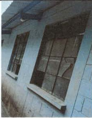
Foto 1: Corredizos 80x80 ventanales existentes.
