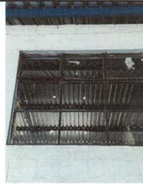
Foto 2: Trabajo y elaboración de balcones de 145x140 hierro entorchado y pintura
