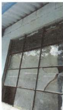
Foto 5: Cambio de vidrio de ventana
