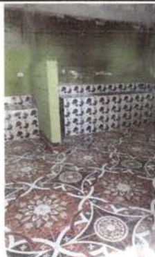
Foto 1: Finalización de Piso de cocina
