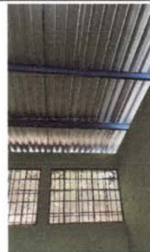
Foto 2: Finalización de altura de cocina
