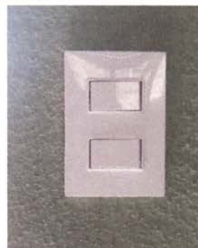
Foto 12: Finalización de Tomacorrientes
