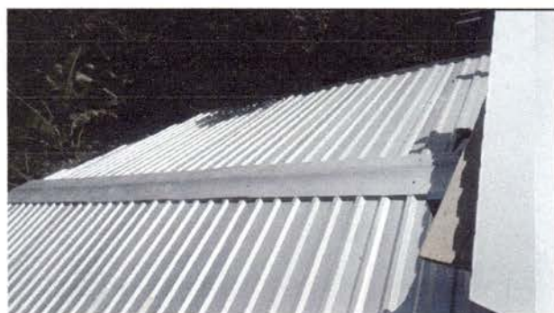
Foto 8: Finalización de Techo de aulas
