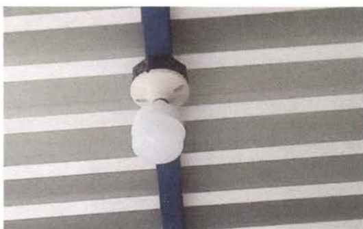
Foto 11: Finalización de Plafonera
