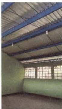
Foto 3: Finalización de techo de cocina
