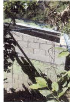
Foto 2: ampliación de altura de cocina
