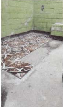
Foto 1: Colocación de Piso de cocina
