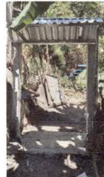
Foto 10: Sustitución de Portón / entrada
