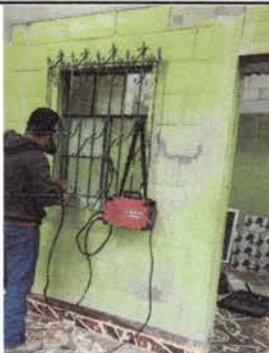
Foto 5: sustitución de ventana
