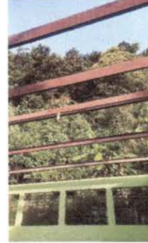
Foto 8: Sustitución de Techo de aulas
