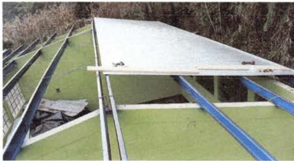
Foto 3: Cambio de techo de cocina
