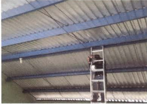
Foto 7: Reparación de cableado
