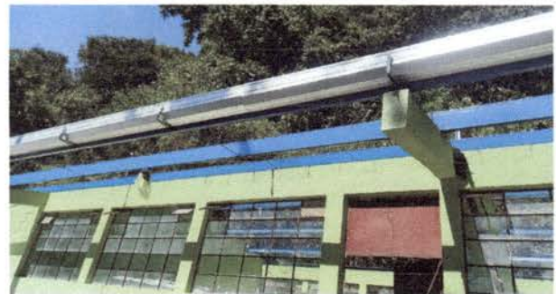
Foto 6: Colocación de canales general
