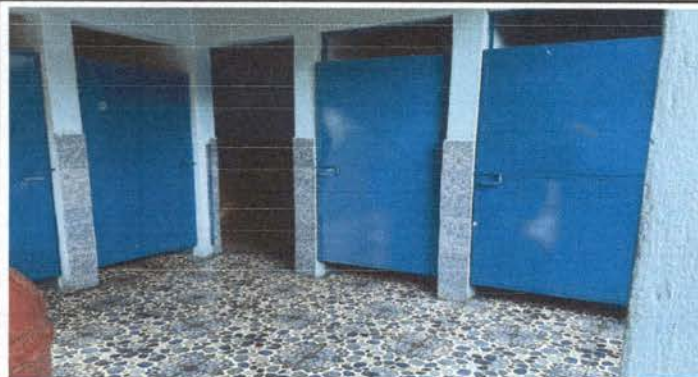
Foto 1: Así quedo los servicios sanitarios con el piso cerámico
