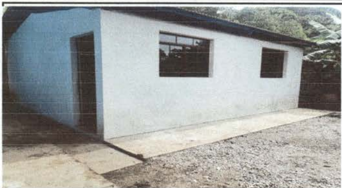
Foto1: Finalizo la ampliacion de la cocina con su construccion de tres paredes, repello ventanas con vidrios, construccion de mesa comedor, puertas pintadas y fundicion de banqueta alrededor de la cocina.
