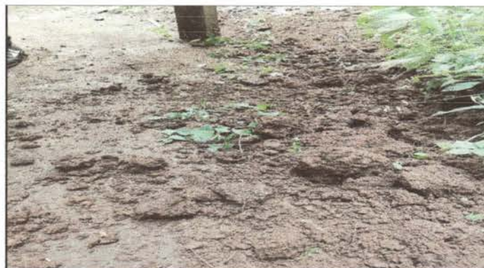
Foto 3: así quedo enterrado los tubos pvc del agua hacia la cocina
