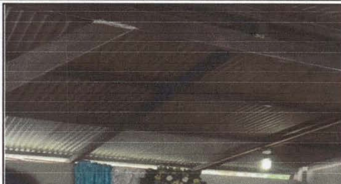
Foto 2 Esta es la estructura de sopote de metal de 6x2 que pue instalado para sostener el techo de la cocina.
