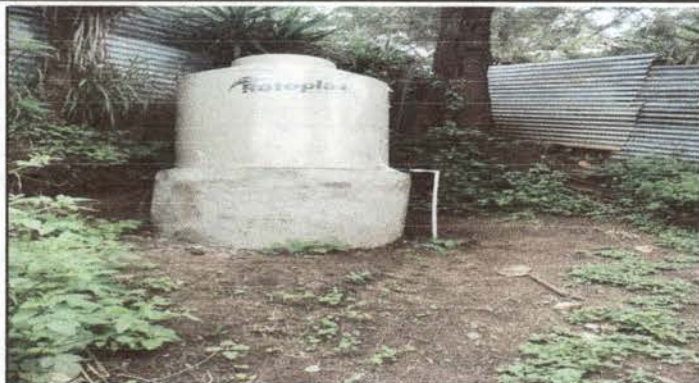
Foto 1: Finalizado la construcción de base e instalación del tinaco con sus accesorios.
