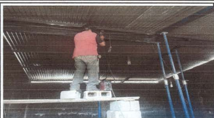
Foto 2: Colocacion de tuvo de 6x2 para sostener el techo de la cocina.
