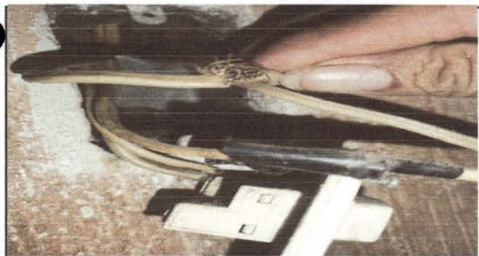
Foto 5: En proceso de instalación de interruptor de la energia en la cosina
