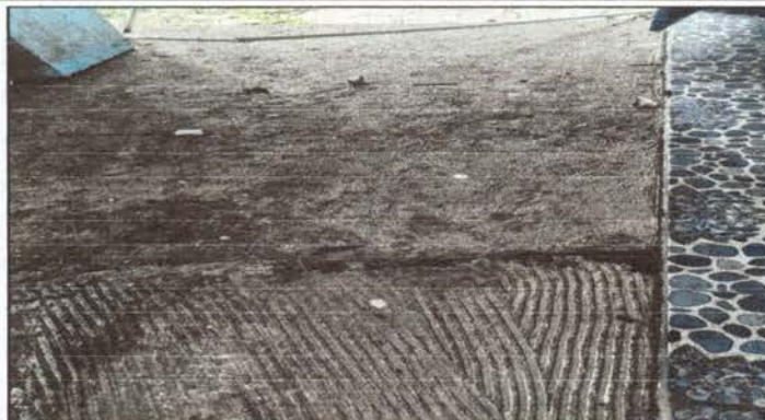
Foto 1: En proceso la sustitucion de piso ceramica en los servicios sanitarios.
