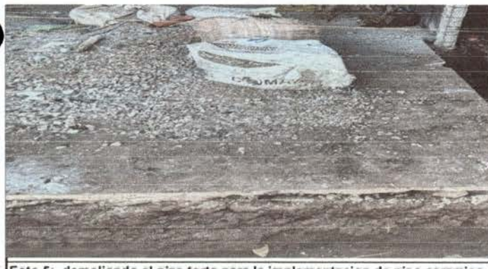
Foto 5: demoliendo el piso torta para la implementacion de piso ceramico.
