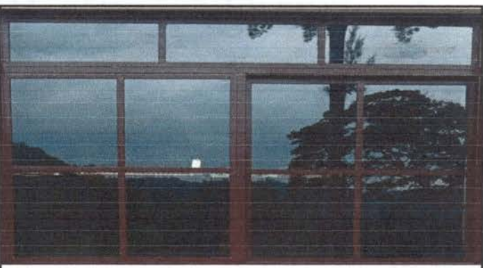
Foto 4: construccion de las ventanas de la cocina
