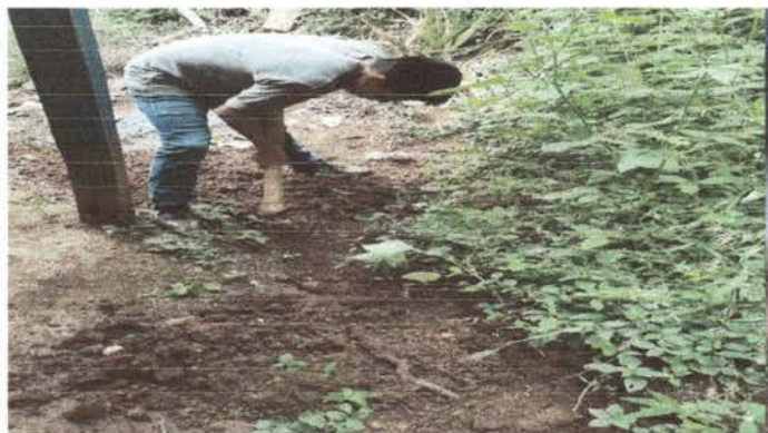
Foto 3: Inicio de Zanjeo para instalar el tubo pvc para conducir el agua a la cocina
