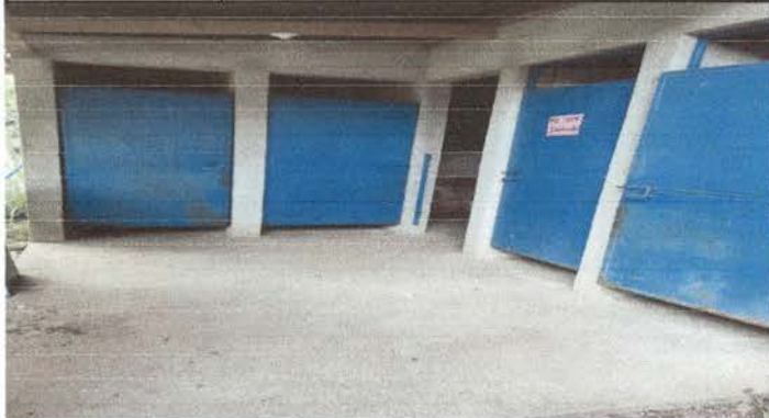
Foto 1: Sustrucción de piso torta de los baños por piso cerámica
