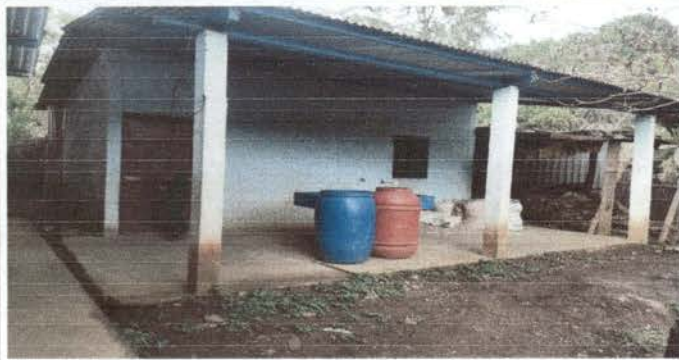
Foto 1: Ampliar, remodelar levantado de paredes y unirlos con cada columnas ya existentes y demoler la pared del centro de la cocina
