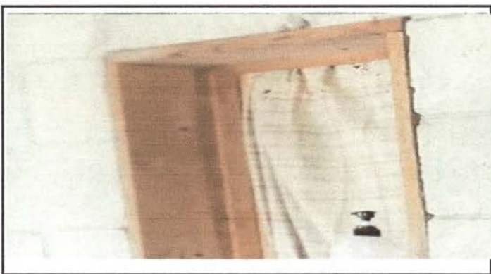
Foto 4: Sustitucion de ventana de madera por ventana de metal
