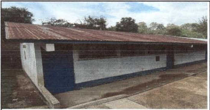
Foto 6: Pintura para pared en aulas en el exterior e interior.
