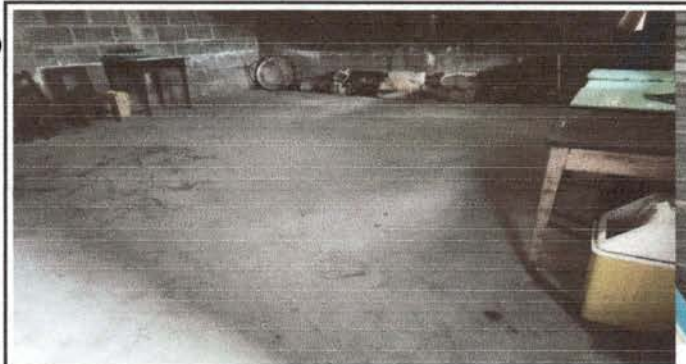
Foto 5: asi estaba el piso antes de demolerlo
