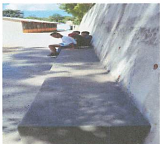
Muro Perimetral con banqueta terminada.
