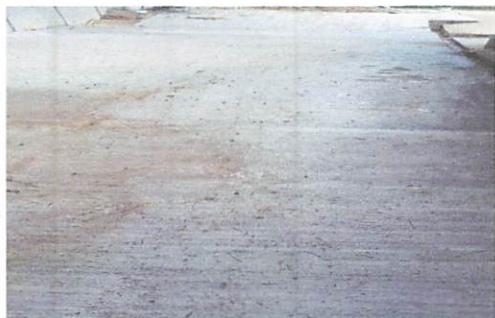
Torta de Cemento terminado, pendiente de Remozamiento 2023
