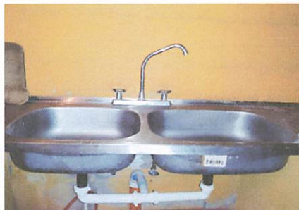
Lavatrastos en cocina reparado Funcionando.
