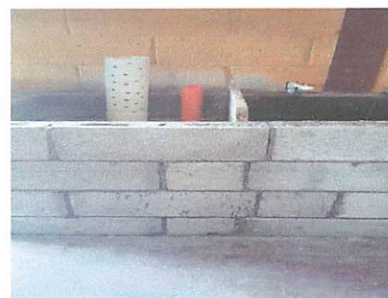
En proceso la construcción de una pila pequeña en cocina 1 lavadero.
