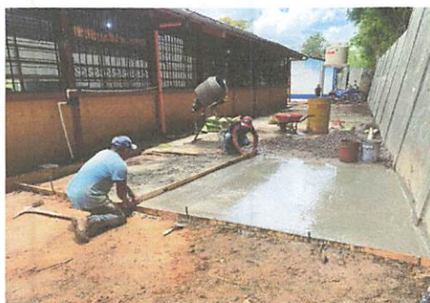
Torta de Cemento en proceso de la fundición
