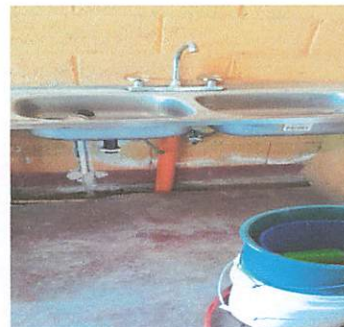
Lavatrastos en proceso de la reparación e instalación de drenaje.
