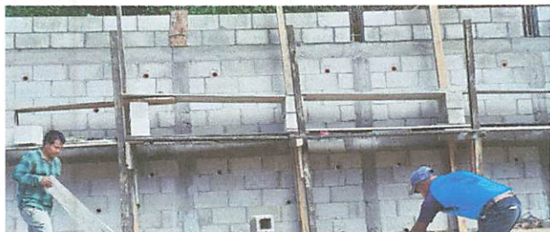
Muro Perimetral en proceso con el 70% de avance de su ejecución.
