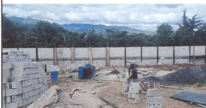
Foto 2: Avances del muro perimetral
