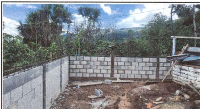
Foto 3: Fundicon de columnas y solera intermedia de muro perimetral
