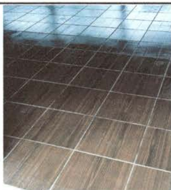
Foto 3: Resultado del piso a cerámica antideslizante
