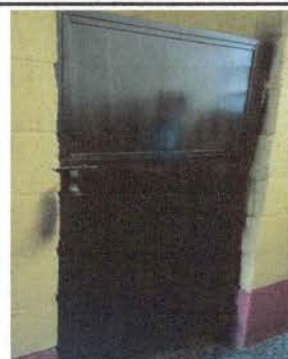
Foto 6: Puertas de los servicios sanitarios
