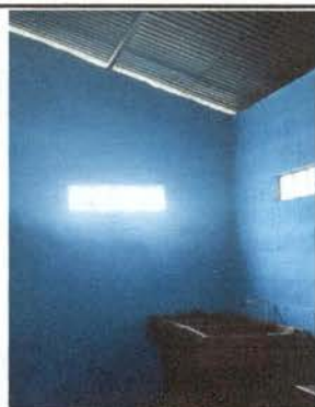
Foto 9: Iluminación adecuada dentro de la cocina
