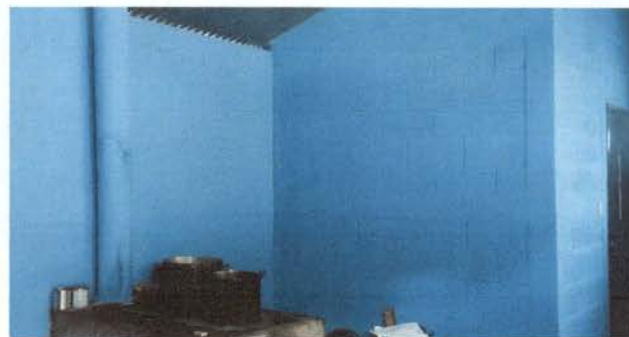
Foto 8: Paredes de la cocina en mejores condiciones
