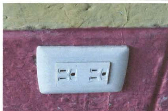
Foto 10: Cambio de tomacorrientes
