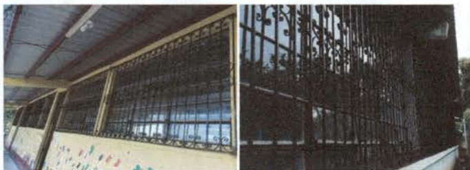
Foto1: Implementación de 18 balcones de estructuras en todas las ventanas.
