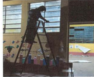
Foto 2: trabajando el mantenimiento de los vidrios que están quebrados
