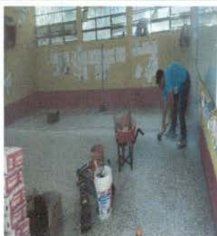
Foto 3: Instalando la sustitución de piso de granito a piso cerámico antideslizante.
