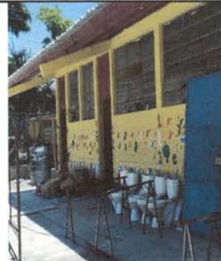
Foto 4: trabajando la sustitución de los sanitarios en malos estados. Y su lavamanos de cemento
