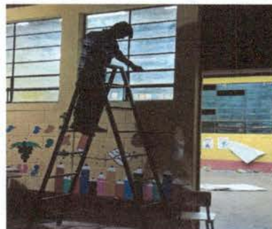
Foto 2: trabajando el mantenimiento de los vidrios que están quebrados
