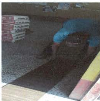
Foto 3: Instalando la sustitución de piso de granito a piso cerámico antideslizante.
