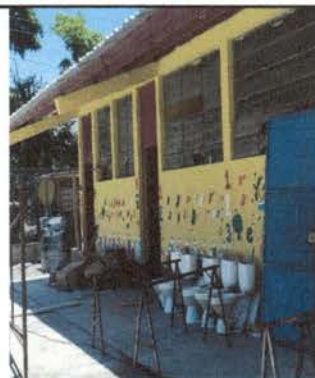
Foto 4: trabajando la sustitución de los sanitarios en malos estados. Y su lavamanos de cemento
