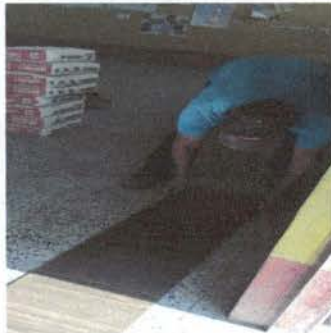
Foto 3: Instalando la sustitución de piso de granito a piso ceramico antideslizante.
