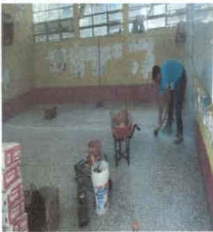
Foto 3: Instalando la sustitución de piso de granito a piso ceramico antideslizante.
