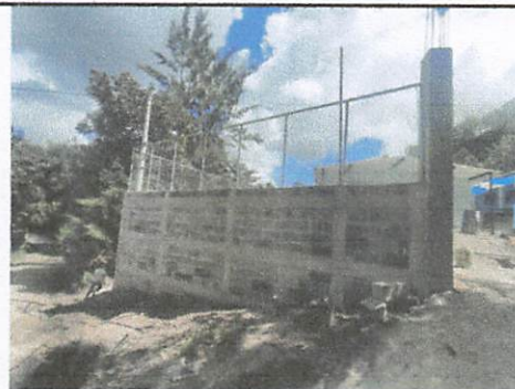
Foto 2: Muro perimetral frontal terminado.
