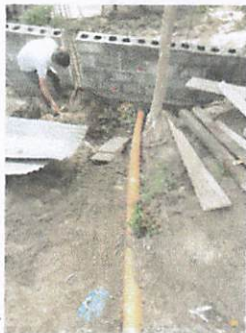
Foto1: Drenaje de agua convergiendo en solo punto hacia la cuneta de la carretera terminado.
