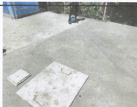
Foto 6: Torta de cemento terminada.
