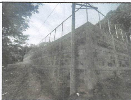
Foto 5: Muro perimetral terminado con la salida de drenaje hacia la cuneta.
