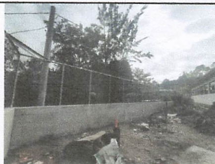
Foto 4: Acabo con repello de la parte interna del muro perimetral terminada.
