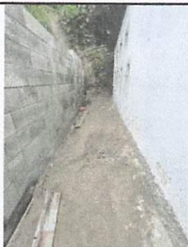
Foto 3: Muro perimetral y drenaje de cocina terminado.
