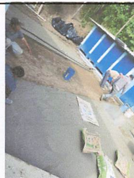
Foto 6: Fundición de la torta por secciones.
