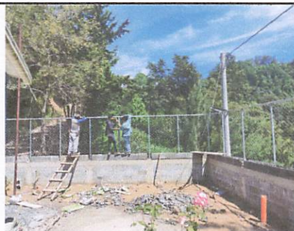
Foto 4: Relleno con selecto en el área que ya tiene el muro de contención.
