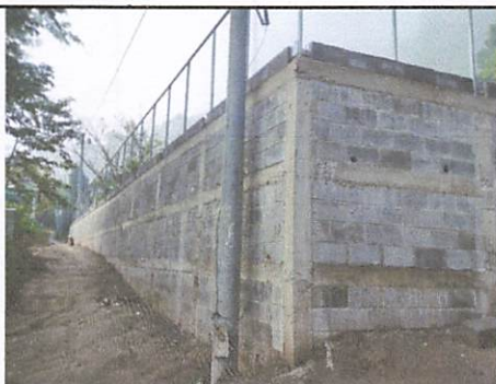
Foto 5: Muro perimetral del lado norte colindante con la calle.
