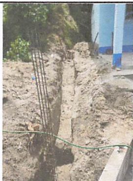
Foto 3: Zanjeado tanto para muro perimetral como para tubería de drenaje
