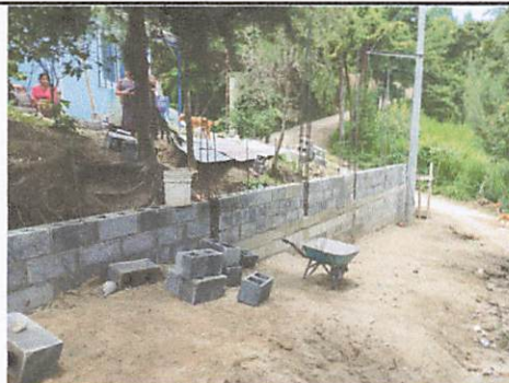
Foto 2: Levantamiento de muro de contención para detener el desbordamiento constante.
