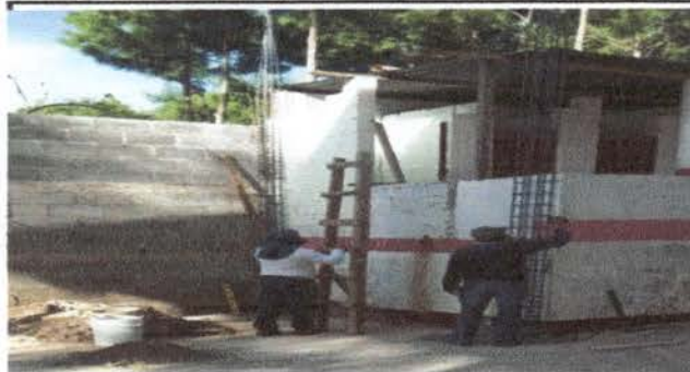
Foto 2: En los sanitarios se inició con la armadura y fundición de columnas que sostendrán la loza de los sanitarios
