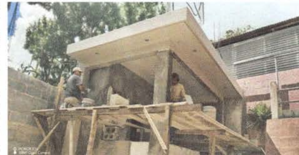
Foto 6: Después de sacar la madera que sostenía la loza se inició con los trabajos de acabados
