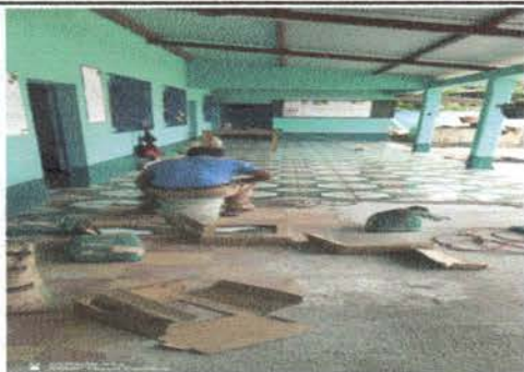
Foto1: Se cambió y corrigió el piso para colocar piso cerámico en todas las aulas y corredor del establecimiento educativo.
