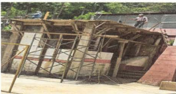
Foto 5: Se foramietó y fundió la loza que sostendrá el tinaco que captará el agua para los sanitarios
