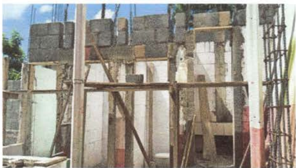
Foto 3: Se reforzaron las paredes de los sanitarios y se subieron hasta la loza para que sea de mejor garantía
