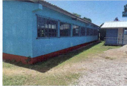
Foto 2: Balcones a 2 salones finalizado el proceso.
