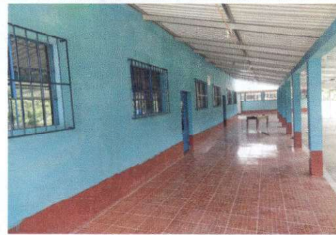
Foto 4: Pintura y balcones a dirección junto a 2 salones más finalizado.
