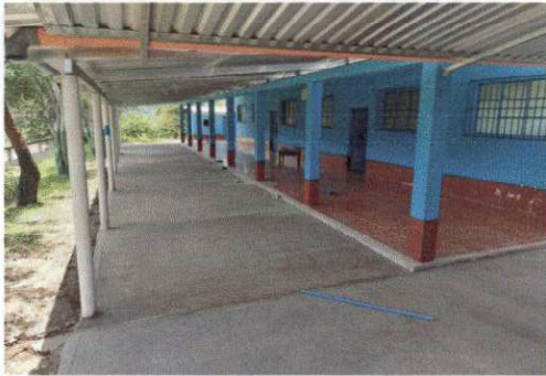
Foto 1: Techado y torta de cemento finalizado.
