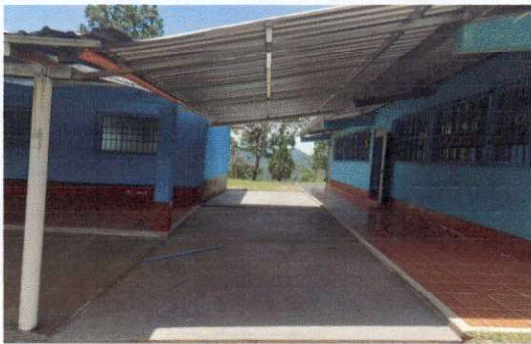
Foto 3: Techado de espacio que sirve como escenario finalizado.
