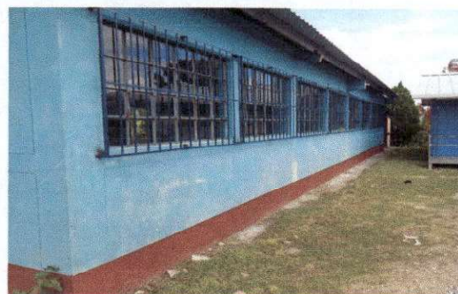
Foto 2: Avance de la colocación de balcones.
