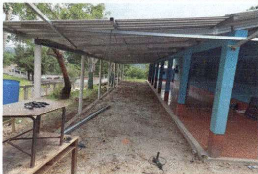
Foto 1: Avances del techado.
