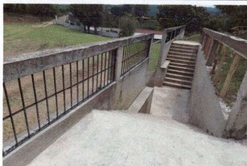
Foto 5: Proceso de reparación de muro de contención y barandas.
