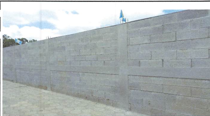
Foto 1: Construcción de pared de muro perimetral finalizado.
