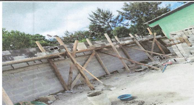
Foto1: Construcción de pared de muro perimetral en proceso.
