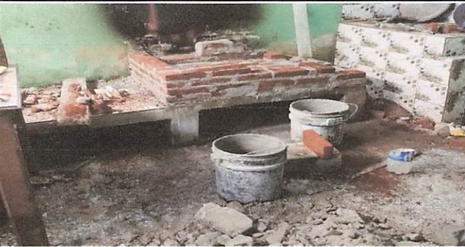
Foto 6: Proceso de construcción del pollo de cocina.
