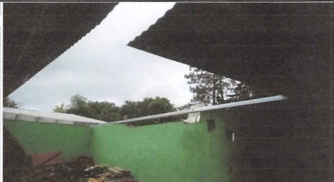
Foto 4: Reparación de pared de cocina en proceso.
