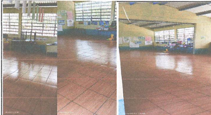
Instalacion de piso Ceramico en los salones de clases
