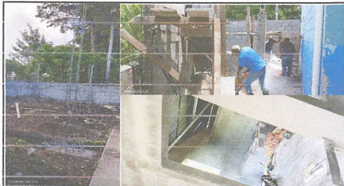
Ampliacion, remodelacion, sutitucion de torta de cemento y sustitucion de estufa rural mejorada
