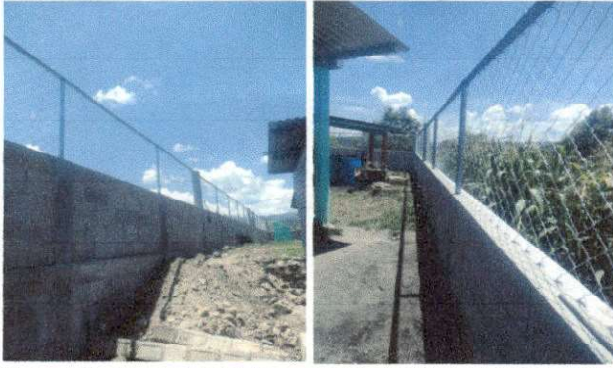
Foto 1: Finalizado muro perimetral con malla
