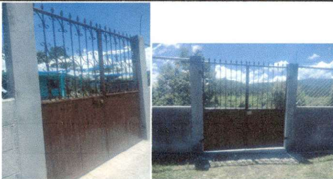
Foto 5: Portón: Fabricación e instalación completa finalización
