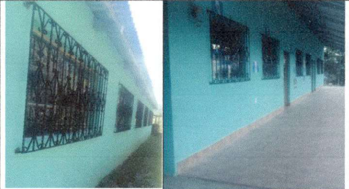
Foto 2: Instalación completa de balcones.
