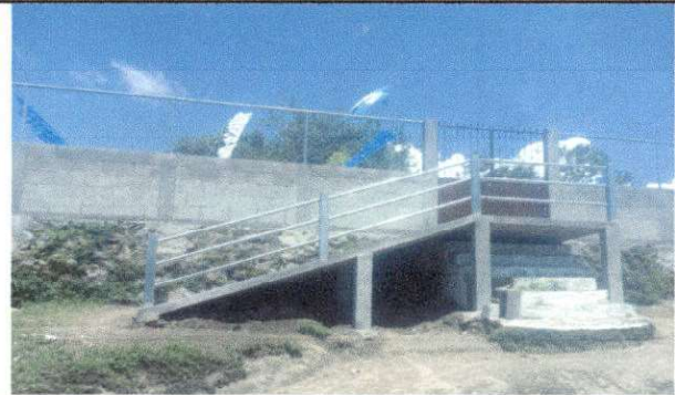
Foto 6: Finalización de Construcción de Rampa con tubo
