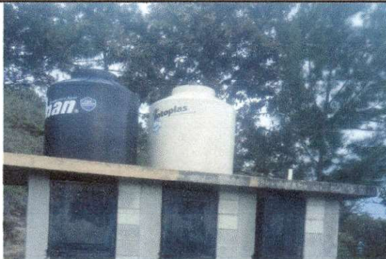
Foto 3: Finalizado Rotoplas instalado
