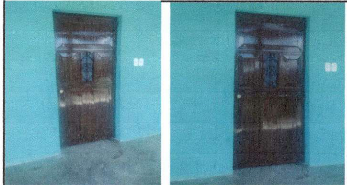
Foto 4: Puerta: Finalización e Instalación completa
