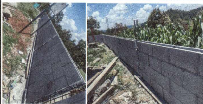
Foto1: Avance de la circulación
