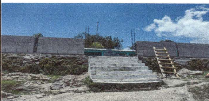
Foto 3: Sustitución gradas por Rampa
