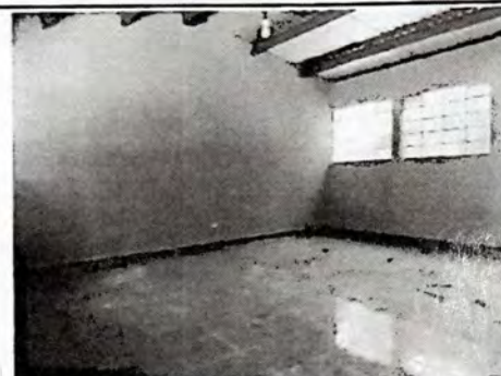
Foto 4: Colocación de piso en aulas
