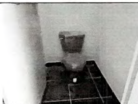
Foto 5: Cambio de baño y colocación de piso
