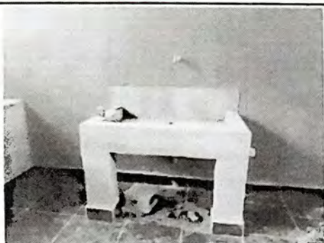
Foto 3: Construcción de pila en cocina y colocación de piso
