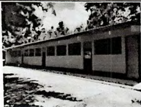
Foto1: Pintura en tres aulas
