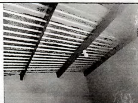
Foto 6: Terminación de instalación eléctrica
