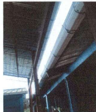
Foto 4: Canales y bajadas de agua pluvial.
