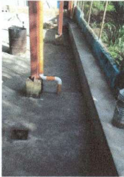
Foto 1: Mantenimiento de pavimento de Cancha.
