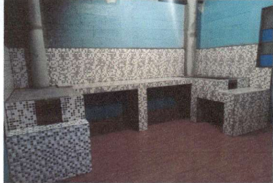
Foto 2: cocina, suministro e instalación de estufa rural, incluye chimenea y plancha de metal.
