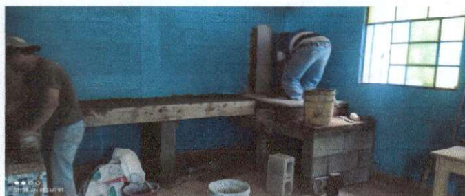
Foto 2: Suministro e instalación de estufa rural, incluye chimenea y plancha de metal.
