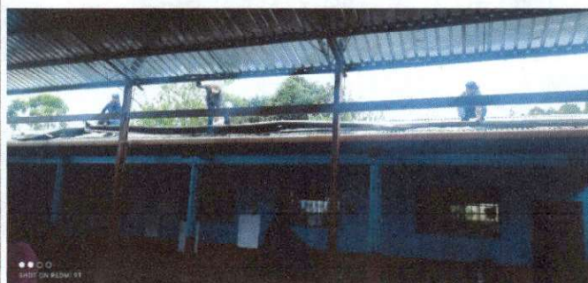
Foto 4: Canales y bajadas de agua pluvial.
