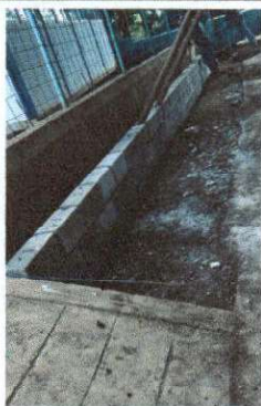
Foto 1: Mantenimiento de Pavimento de cancha.
