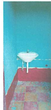
lavamanos y sistema de agua terminados
