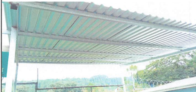
techado de cocina de leña terminado
