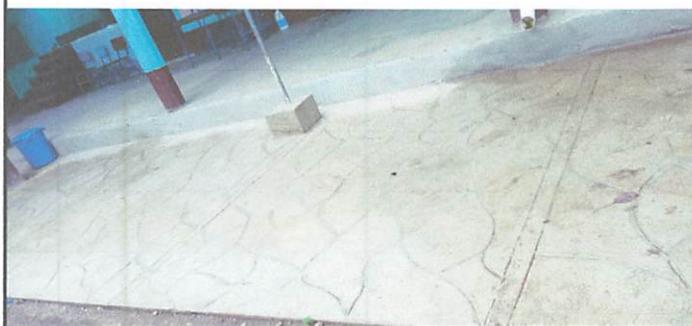
torata de cemento terminada
