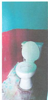
servicios sanitarios y sistema de agua terminados
