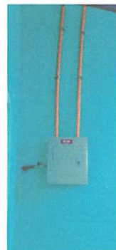
caja central de 8 flípones colocada
