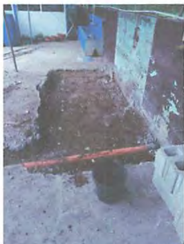
preparacion del lugar donde se construyó la pila,
