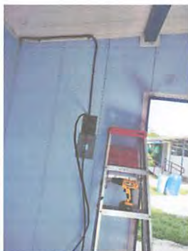
colocacion de energia electrica en la cocina
