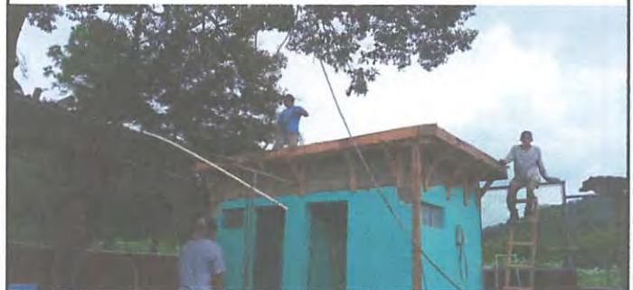
fundición de la terraza en el area de sanitarios
