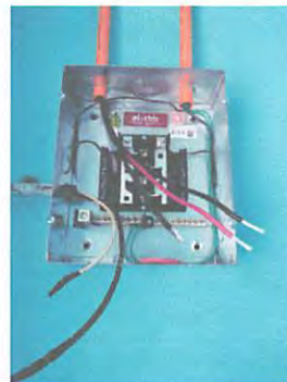
cambio de cajas de flipones, para mayor soporte de energía eléctrica
