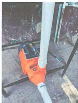
colocación bomba periférica de agua.
