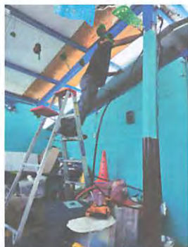
cambio de líneas principales de energía eléctrica
