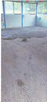
preparacion de soporte para piso en el salon de clases
