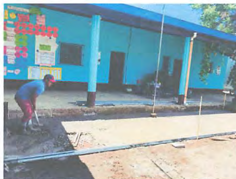
fundición de torta de cemento
