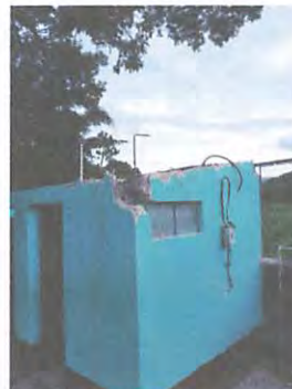
preparacion y reforzamiento de paredes para fundir terraza de soporte para dos tinacos
