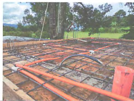
preparación de cableado en terraza
