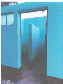
desinstalacion de sanitarios y lavamanos
