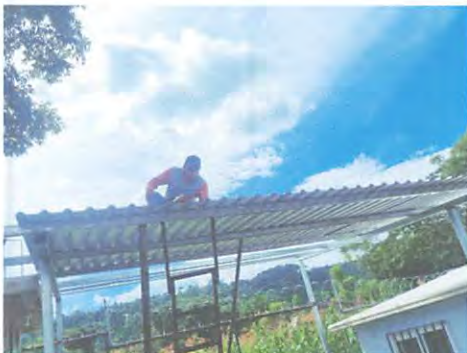
lamina en el techo del area de cocina
