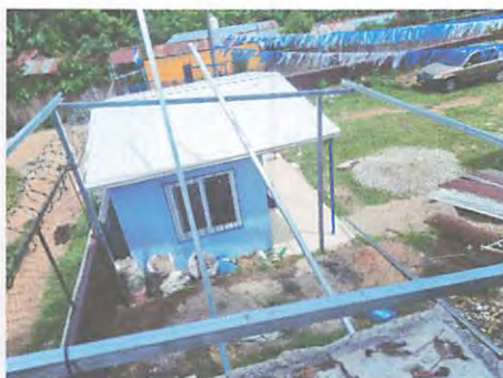
estructura metálica para techo de cocina de leña
