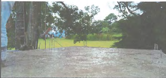
fundición de terraza
