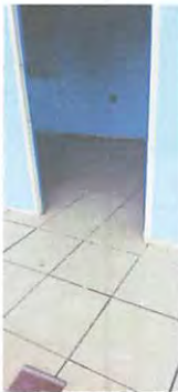
colocacion de piso de cocina y su corredor
