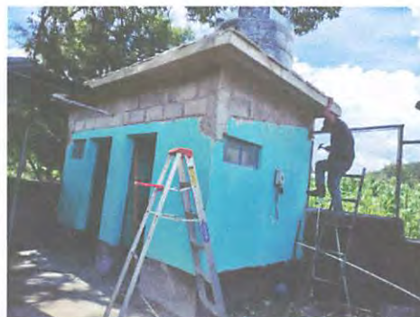
colocación del Tinaco de agua, con capacidad para 8 toneles
