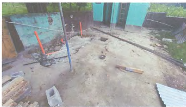
preparación de tubería de drenaje y agua potable
