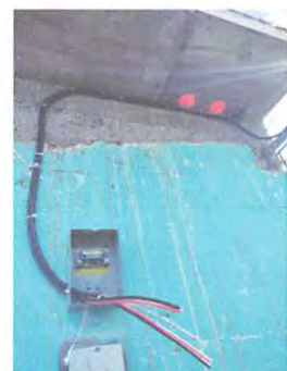
cambio de caja y línea principal para la bomba de agua
