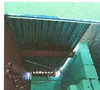
techado de sanitario en mal estado, por lo que se realizara una terraza, que ayudará a los sanitarios y sera de soporte para el tinaco de agua.
