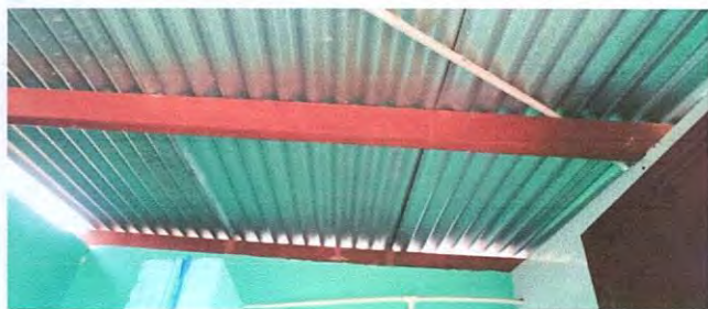
plomería en pila, sanitarios y lavamanos
