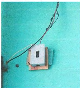
Cambio de caja electrica y cableado para la bomba, salones y cocina
