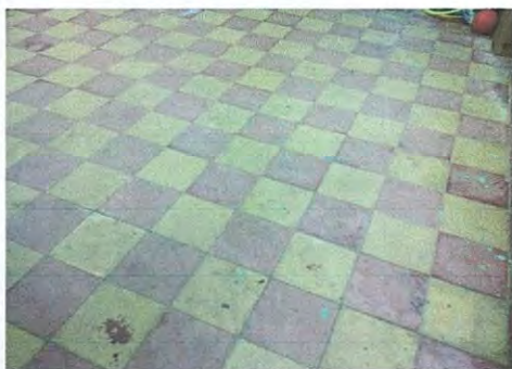
piso del salon de la direccion completamente deteriorado, por lo que se realizará el cambio por piso cerámico.
