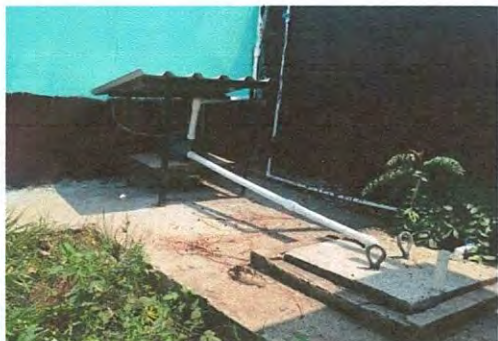
cambio de bomba y plomería
