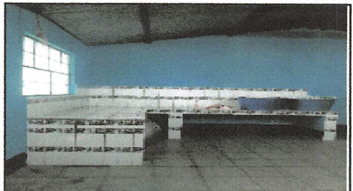
Foto 4 : construcción de Top de cocina
