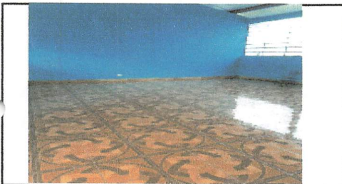
Foto 5: Instalacion de piso en aulas.
