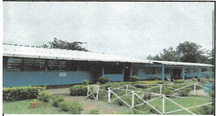
Foto 2. Pintura en paredes
