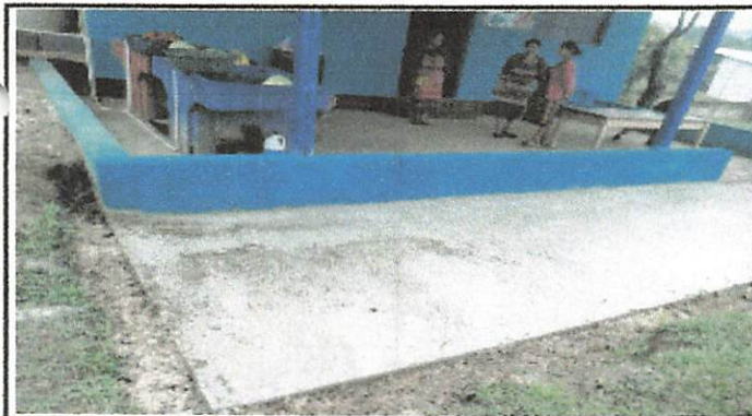
Foto 3 : Construccion de muro de contención en cocina
