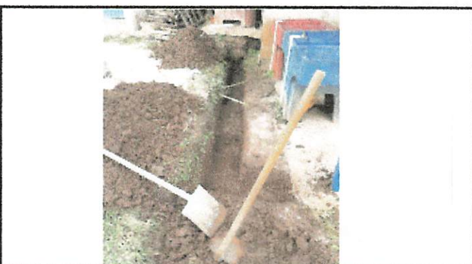
Foto 4 Construcción de Muro de contención area de cocina
