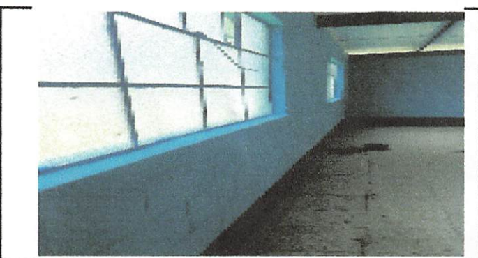
Foto No. 6 sustitución de viadrios
