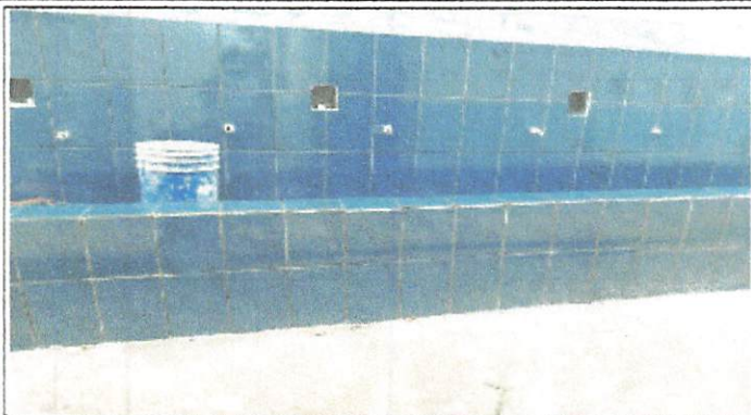
Foto 1: Remodelacion de chorros para lavamanos.
