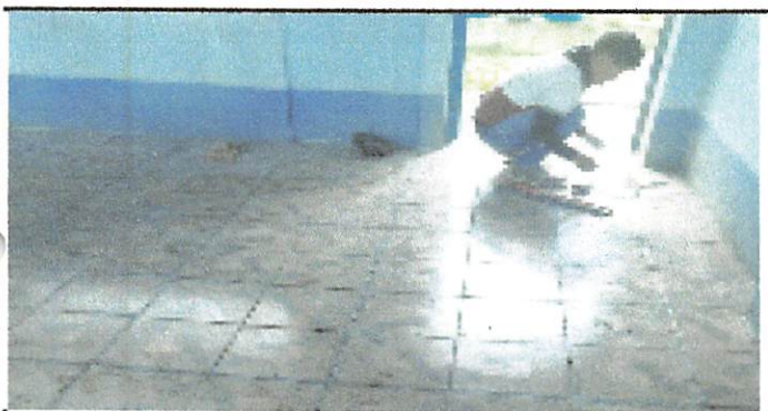
Foto 5: Instalacion de piso en aulas.
