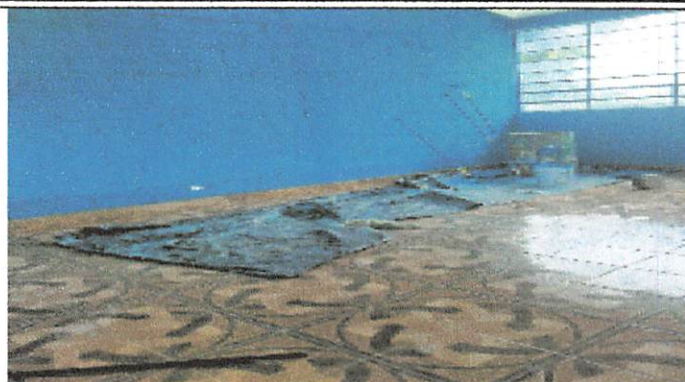
Foto 2: Pintura en paredes
