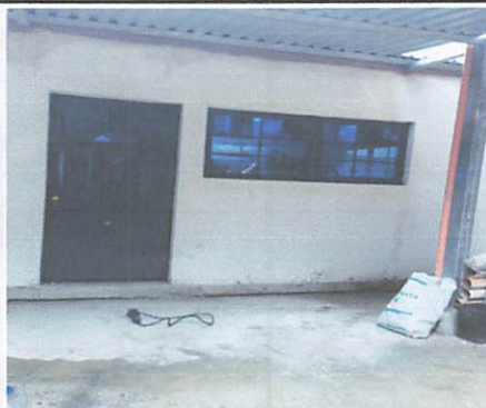
Foto 3: Instalación de puerta y ventanas.
