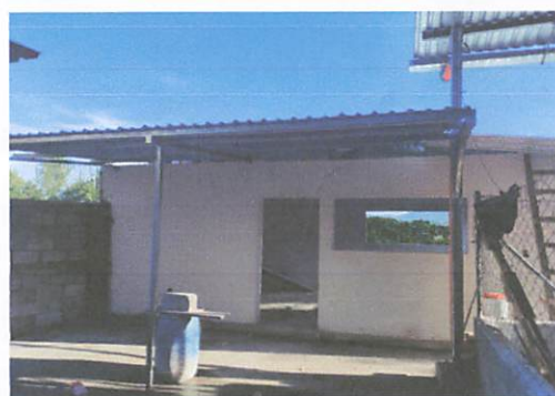
Foto 2: Trabajos de albañilería en cocina finalizados.
