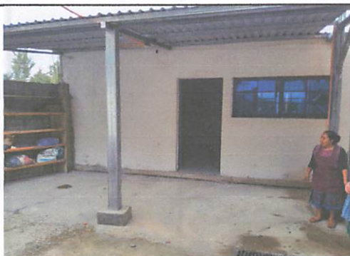
Foto 5: Fundición de piso de corredor.
