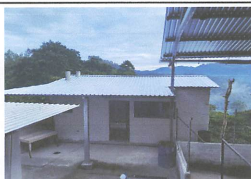
Foto 6: Techado con lámina troquelada.
