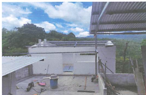
Foto 6: Instalación de techado.
