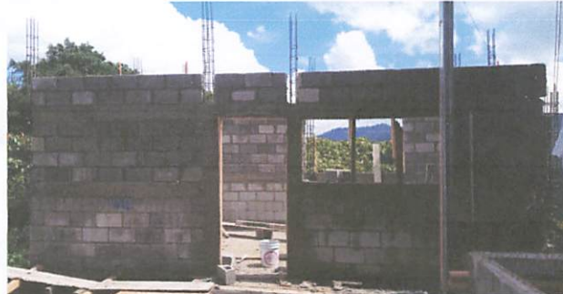
Foto 2: Construcción de cocina.
