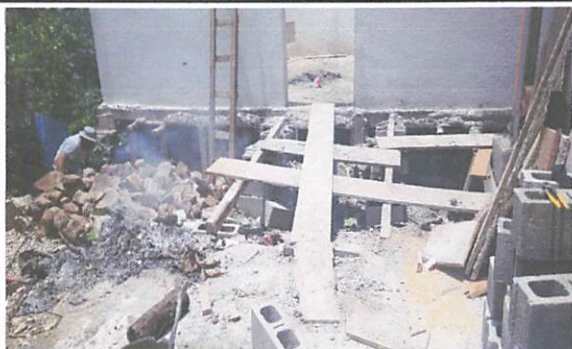
Foto 5: Relleno para corredor de cocina.
