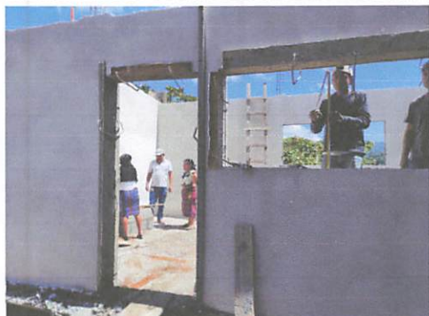
Foto 3: Instalación de puerta y ventanas.
