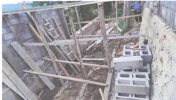
Foto 1: Levantado de paredes y terraza de bodega sobre la que se construirá la cocina.
