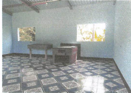
Foto 2: Colocacion de piso
