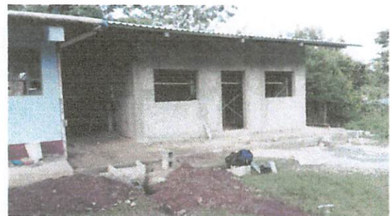
Foto 4: Finalización de cajón con techo
