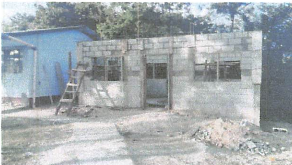
Foto 3: Levantado de paredes
