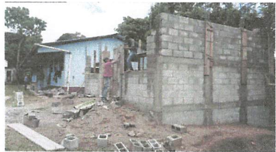
Foto 2: Levantado de muro
