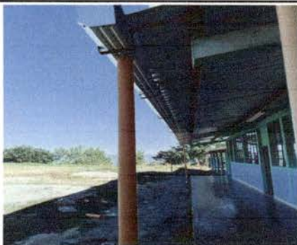
Foto 5: INSTALACION DE CANALES EN CORREDOR DE LAS AULAS
