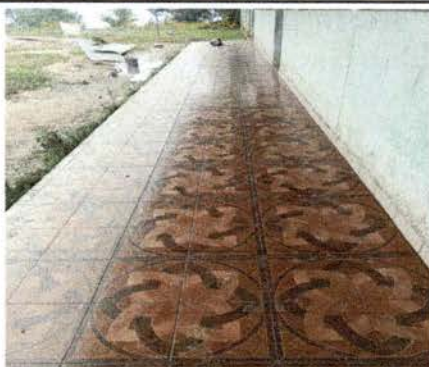
Foto 3: SUSTITUCIÓN DE PISO POR PISO CERAMICO, CORREDOR DE AULAS.
