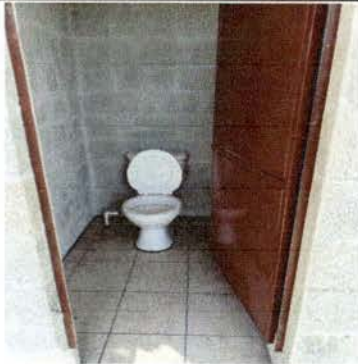
Foto 1: MEJORAMIENTO DE SANITARIO DE LA ESCUELA
