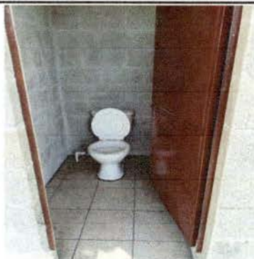
Foto 1: MEJORAMIENTO DE SANITARIO DE LA ESCUELA
