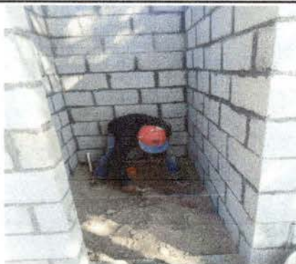
Foto 1: MEJORAMIENTO DE SANITARIO DE LA ESCUELA
