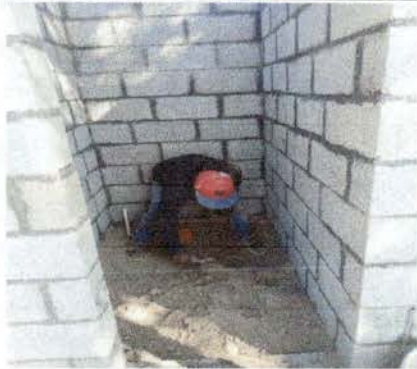
Foto1: MEJORAMIENTO DE SANITARIO DE LA ESCUELA
