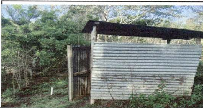
Foto 1: MEJORAMIENTO DE SANITARIO DE LA ESCUELA
