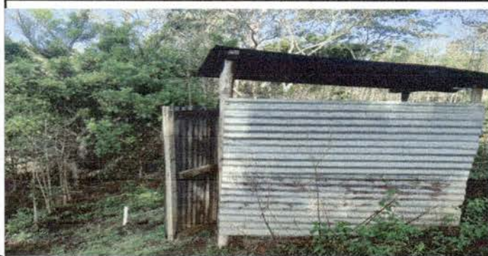
Foto 1: MEJORAMIENTO DE SANITARIO DE LA ESCUELA
