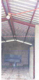
Foto 1: INSTALACIÓN DE ENERGÍA ELÉCTRICA.
