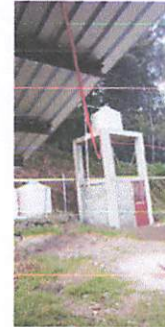
Foto 4: CONECCIÓN DE DEPÓSITO DE AGUA A SANITARIOS.
