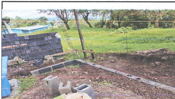
Foto 2: INICIO DE LA CONSTRUCCION DE PAREDES .
