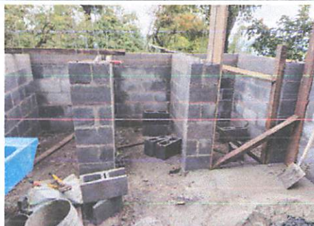
Foto 3: CONSTRUCCIÓN DE PARDES COMPLETADAS.
