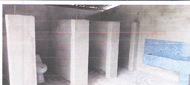
Foto 5: PAREDES REPELLADAS E INSTALACIÓN DE SANITARIOS.
