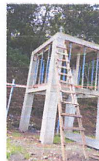
Foto 4: CONSTRUCCIÓN DE TORRE PARA DEPOSITO AEREO DE 5,000 LT CON BOMBA SUMERGIBLE + INSTALACION AUTOMATIZADA CON ELECTRONIVEL.
