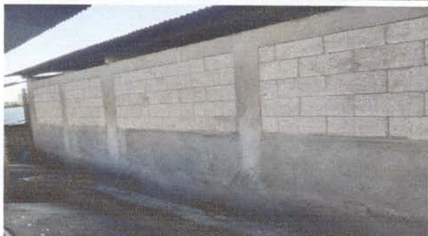
Foto 5: Terminación de cernido gris en pared exterior.
