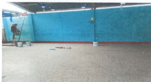
Foto 4: Finalización de impermeabilización de pared exterior.
