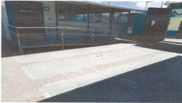
Foto 7: Finalización del piso de torta.
