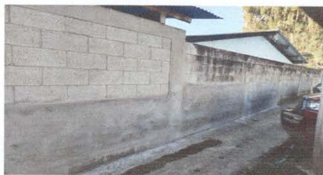
Foto 6: Terminación de cernido gris en pared exterior.
