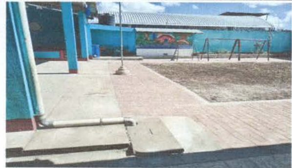
Foto 8: Sustitución de pila.
