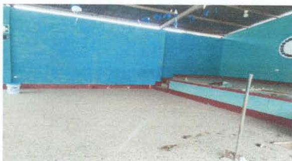
Foto 3: Finalización de impermeabilización de pared exterior.
