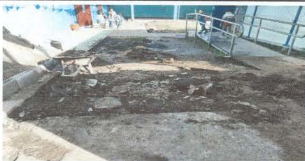
FOTO 11: Deterioro de torta sustituido por adoquín
