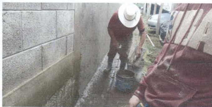
Fotografía No. 5: Problema de filtración de agua hacia la escuela, pared de la parte posterior donde se origina el problema.
