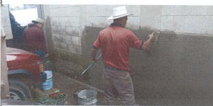
Fotografía No. 6: Necesidad de canales y bajada de agua pluvial, impermeabilización de pared para evitar la continuidad del daño por filtraciones.
