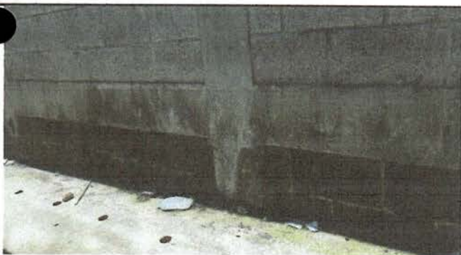
Fotografía No. 5: Problema de filtración de agua hacia la escuela, pared de la parte posterior donde se origina el problema.
