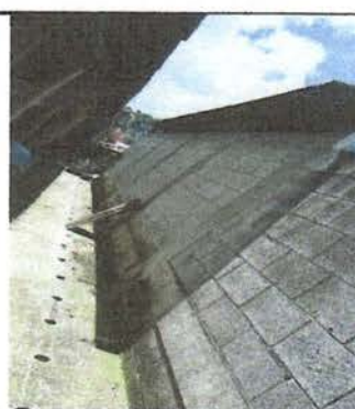
Fotografía No. 6: Necesidad de canales y bajada de agua pluvial, impermeabilización de pared para evitar la continuidad del daño por filtraciones.
