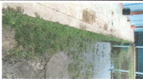
FOTO 12: Deterioro de torta sustituido por adoquín, acumulación de agua.
