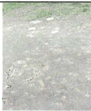
Fotografía No. 10: Mal estado de la cobertura de cemento del patio de la Escuela De Párvulos, debido a las lluvias.
