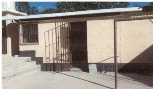
Foto7: Rrelleno de la cocina movido y con baranda puesta
