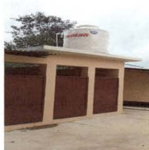
Foto 4: Fundición de una terraza con tinaco puesto
