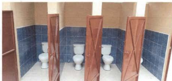
Foto1: Colocación de sanitarios lavables
