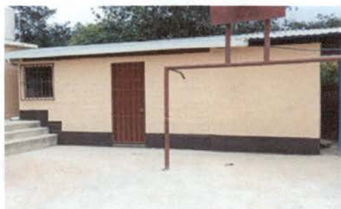
Foto 5: Ampliación de cocina terminado
