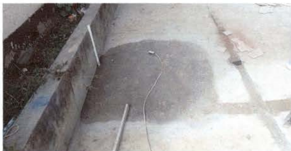
Foto 3: Construcción de fosa séptica terminado
