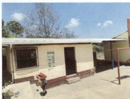
Foto 5: Reparación de cocina
