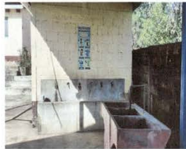
Foto 10: Construcción de nuevos lavamanos
