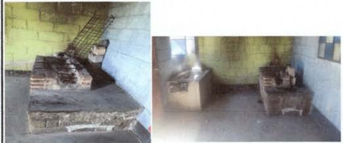
Foto 8: Reparación de estufas ahorradoras
