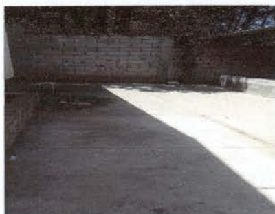
Foto 3: Construcción de fosa séptica
