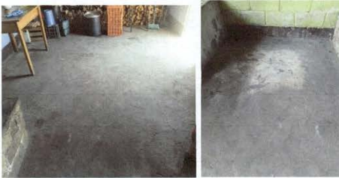
Foto 9: Reparación de piso de la cocina
