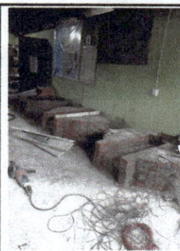
Foto 6: Avance en construcción de poyos de cocina
