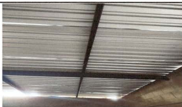
Techado de cocina terminado
