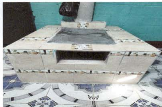
Así quedó la estufa mejorada completamente terminada
